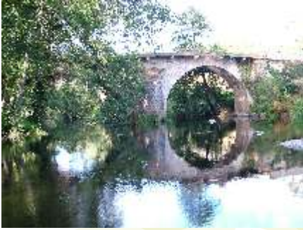
Ponte de Neira
