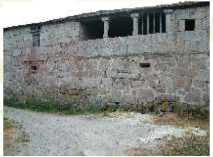
Detalle da solaina
